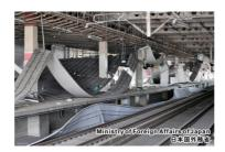
Roofs collapsed on the Tohoku Shinkansen platform at Sendai Station. ホームの屋根が崩落した仙台駅(東北新幹線ホーム)。
