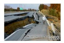
A 150m section of the Joban Expressway subsided in the earthquake. 震災によって、常磐自動車道に150mに 及ぶ陥没と波打ちが発生。
